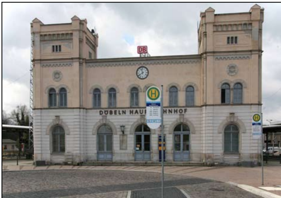
Ein architektonisches und eisenbahnhistorisches Highlight in Mittelsachsen - der altherwürdige Hauptbahnhof in Döbeln. Leider inzwischen fast auf dem Abstellgleis.
