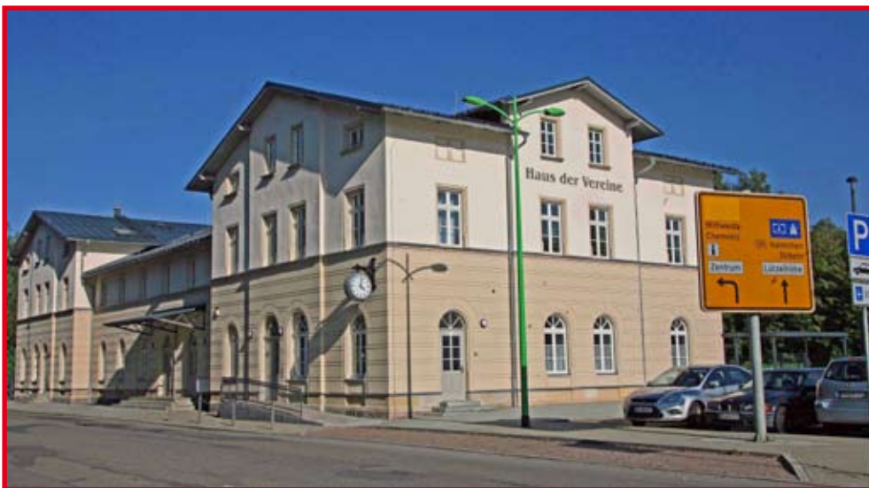
Ein bemerkenswertes und sachsenweites Beispiel für die Rettung von erhaltenswerter Bausubstanz: Der Ausbau des ehemaligen Frankenberg Bahnhofs zum „Haus der Vereine“.
