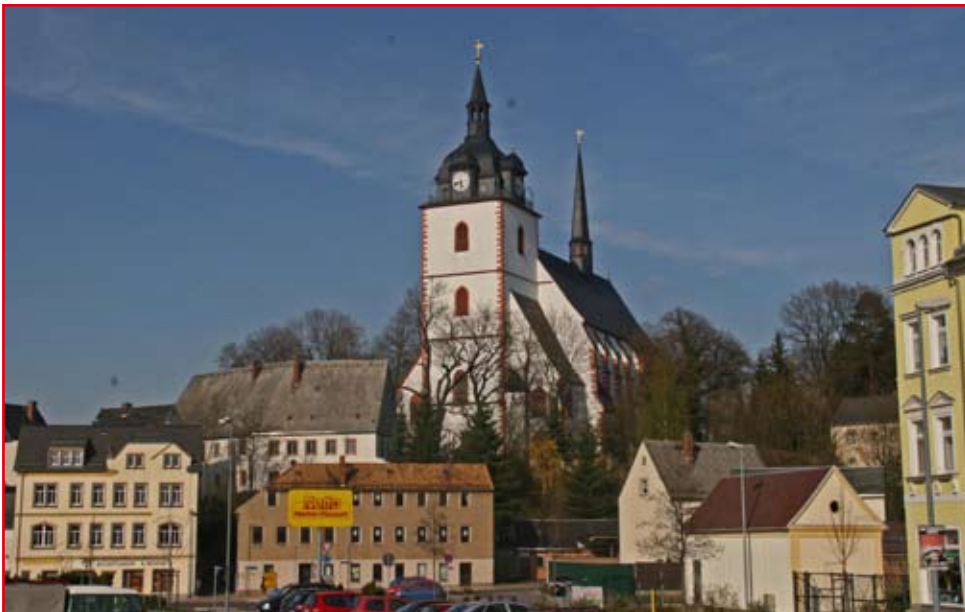
Die markante Stadtkirche von Mittweida. Hoch thront sie über der Stadt und - in diesem Bereich - einem großen Loch, gefüllt mit Netto-Markt und riesigem Parkplatz. Mittweida feiert vom 20. bis 22. August sein Altstadtfest
