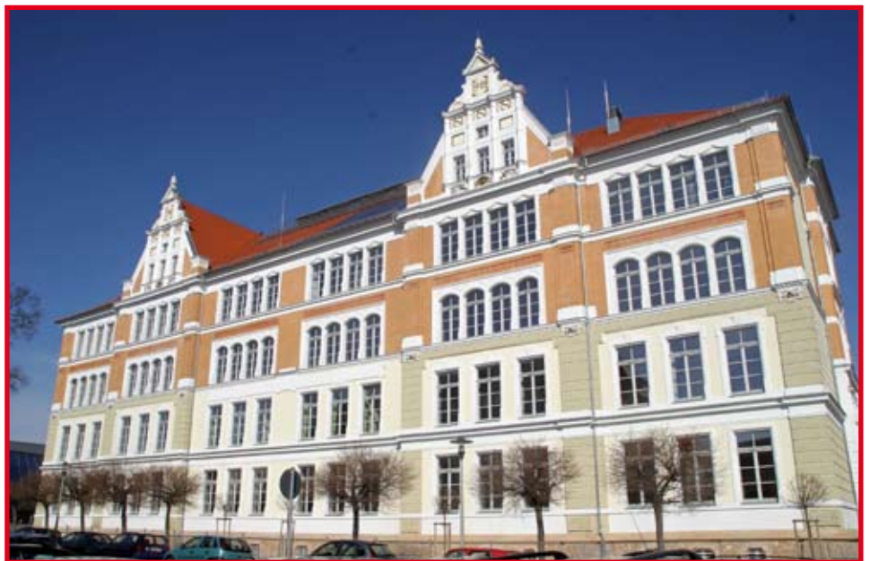
Die Rekonstruktion und Sanierung von Schulen hat im Freistaat Sachsen einen relativ hohen Stellenwert. Hier die im neuen Glanz erstrahlende Clara-Zetkin-Mittelschule in der Kreisstadt
