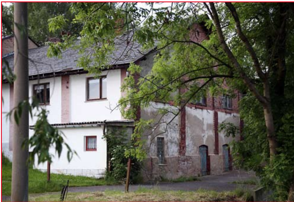
Das „einladende“ Gebäude der Geringswalder „Brauerei“ – hinter der mittleren Stalltür hätten sich die Räume von SOLID befinden sollen
